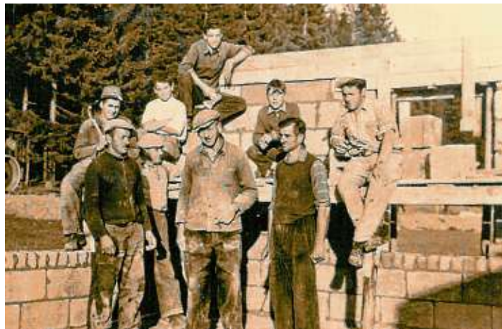
Der Blick über den Tellerrand war bei der Baufirma Demattio schon immer gegeben: Hier Stefan Demattio mit der Belegschaft.
